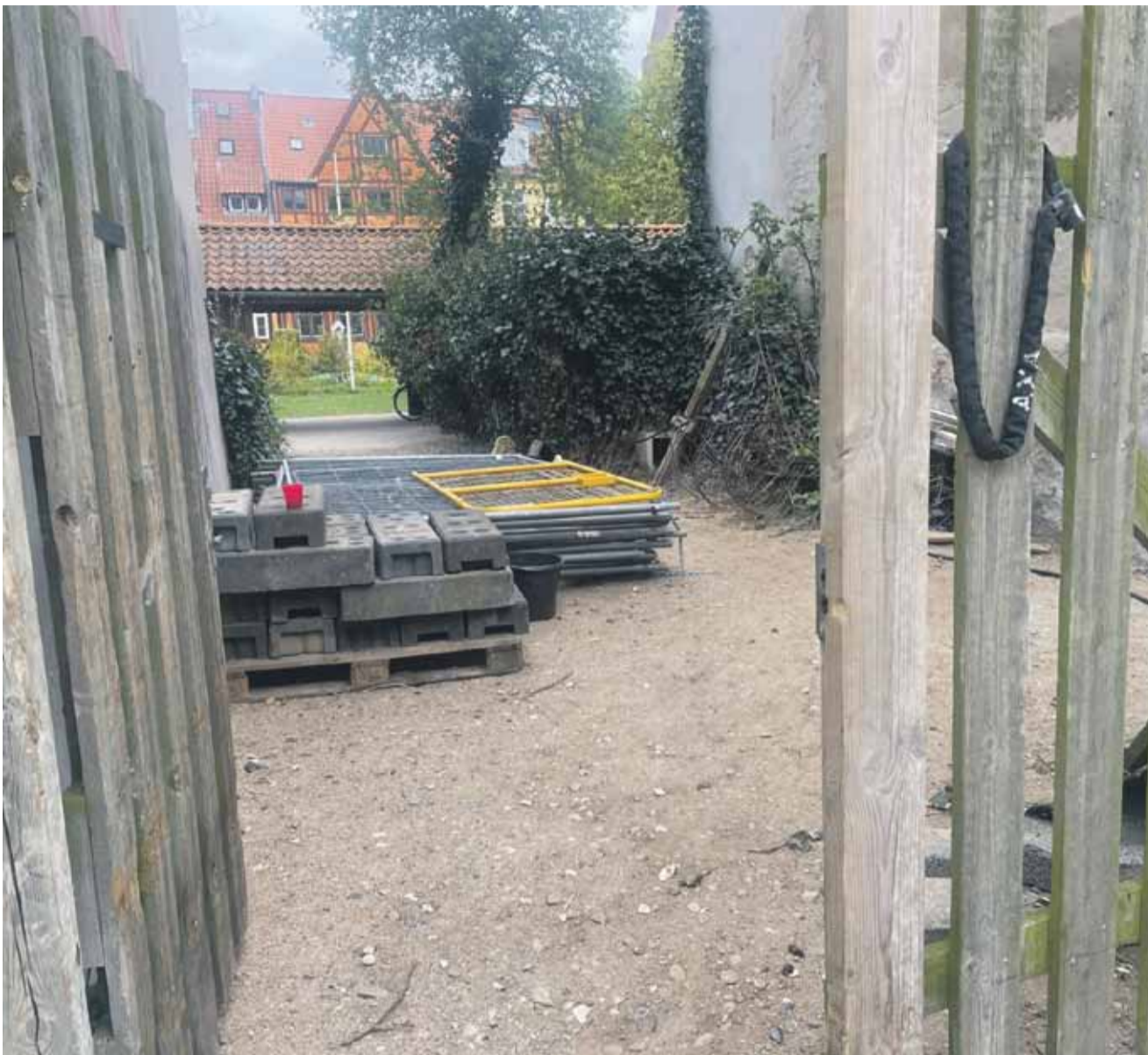
Trods de kritiske røster gennem adskillige år opføres der nu et enfamiliehus. Der er ved at blive gjort klar.
