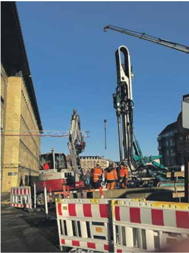
Der kræves tungt udstyr til renoveringen af Wilders Bro. Ingeniørerne har nøje beregnet, hvor og hvordan det skal placeres for at sikre stabilitet under arbejdet.
