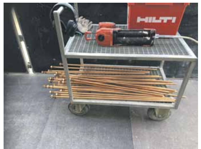
Bronzeankre klar til montering Foto- Sofie Amalie Klougart.
