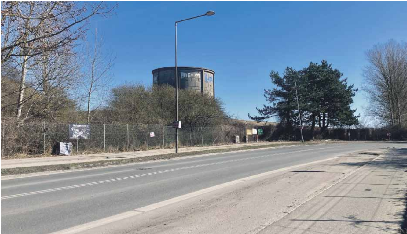
Billedet er taget på Forlandet med ryggen mod kolonihaverne. Det er her højbanen, ihht. tegning skal skære igennem / foto af Max Van de Wiele
