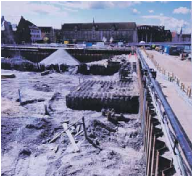
Under udgravningen fandt man fundamentet til en mastekran, som var større end den, der står ude på Nyholm.
