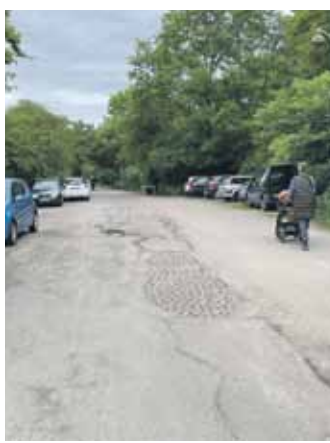
Sikker skolevej på Refshalevej
