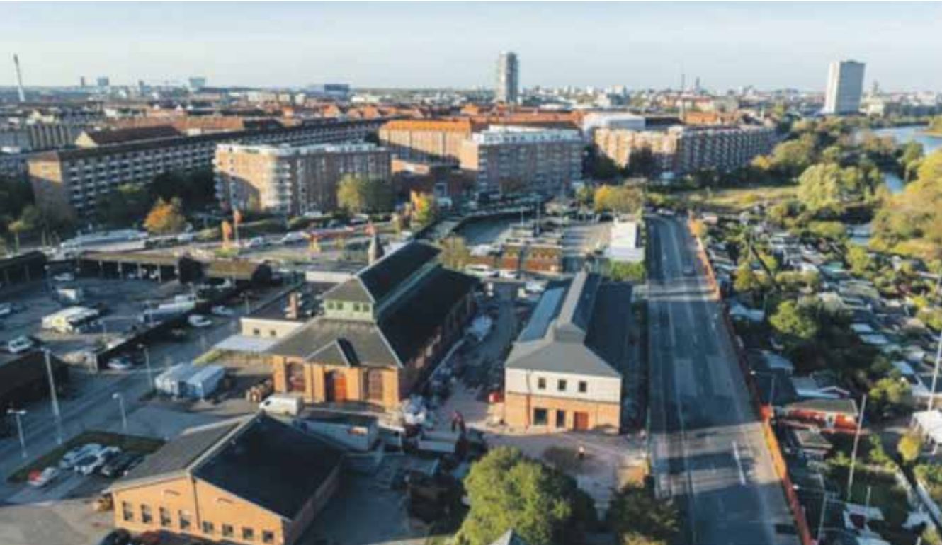
Den store varmepumpe skal installeres i den gamle pumpestations-bygning på Kløvermarken Pumpestation. HOFOR Fjernvarme har for nyligt opført en ny driftsbygning lige ved siden af - arkitektonisk inspireret af den bevaringsværdige bygning fra 1901. Foto: HOFOR
