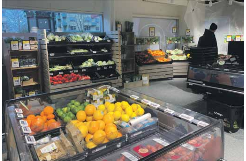
Den nye frugt- og grønt-afdeling forventes at stå klar i februar, mens den fuldt ombyggede butik med nye kølere, reoler og øvrigt inventar står færdig midt i marts
