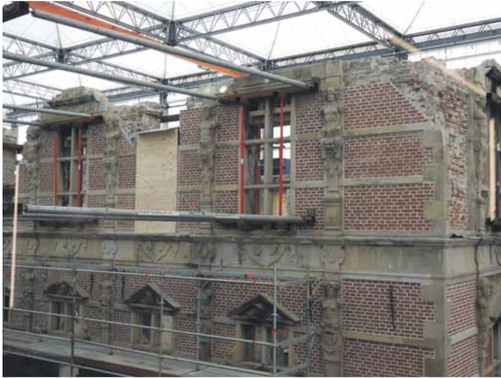
Murstykke, Mock-up af facaden. Lavet for at bestemme både fugernes og facadens udtryk
